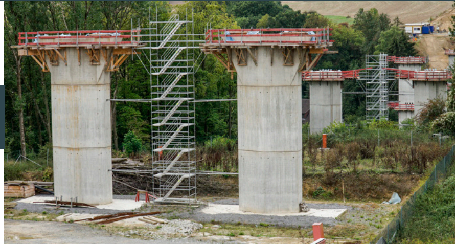
Foto: Baustelle der A44-Talbrücke Angerbach (Hans-Werner Zimmermann)
